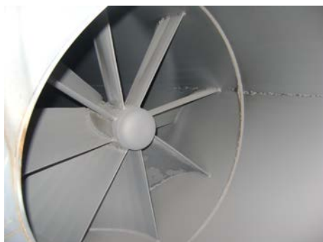
Fig. 5: Inspeção das aletas do SE / Inspection of the SS
