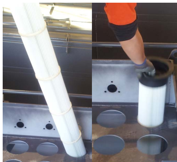
Fig. 2: Manga plissada sendo adicionada em sua respectiva furação / Manga plegada adicionada en su respectivo agujero / Pleated bag being added to its respective perforation / Mise en place d'une poche plissée sur le trou respectif
