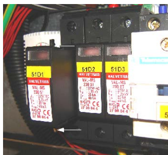
Fig. 6: Substituição dos supressores / Sustitución de los supresores / Replacing suppressors / Substitution des limiteurs
