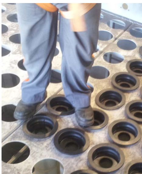
Fig. 5: Posicionamento final da manga feito pelo montador / Posicionamiento final de la manga hecha por el montador / Final positioning of the bag done by the assembler / Positionnement final de la manche fait par le monteur
