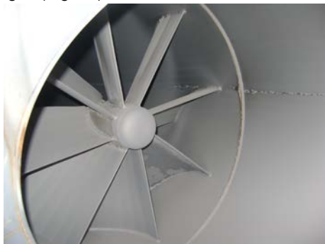
Fig. 8: Inspección del SE / Inspection du SE
