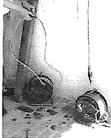
Abrir la válvula de bola entre los enrolladores de mangueras (elevando ésta) y desairear por la válvula de bola lado salida.
