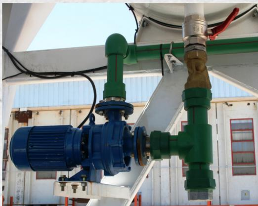
**Sistema dosificación de agua** compuesto por electrobomba de 3 HP, caudalímetro lanza impulsos marca Maddalena de Ø2", cañerías, mangueras de conducción, llaves esféricas, etc. Regador de descarga en la tolva final de cinta.
