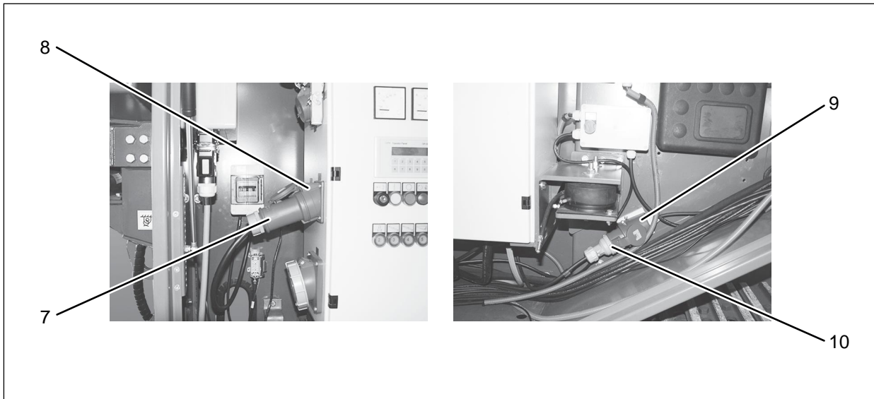
Abb. 3.12: Conectores y cajas de enchufe
