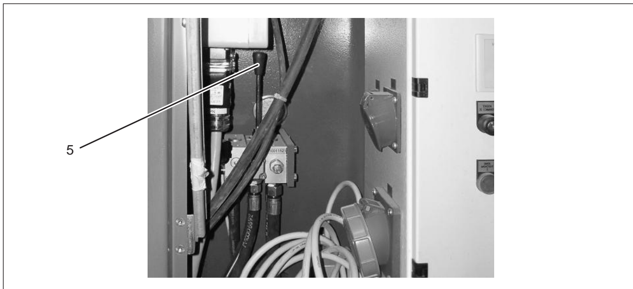
Abb. 2.50: Distribuidor de la cinta de descarga de la machacadora
