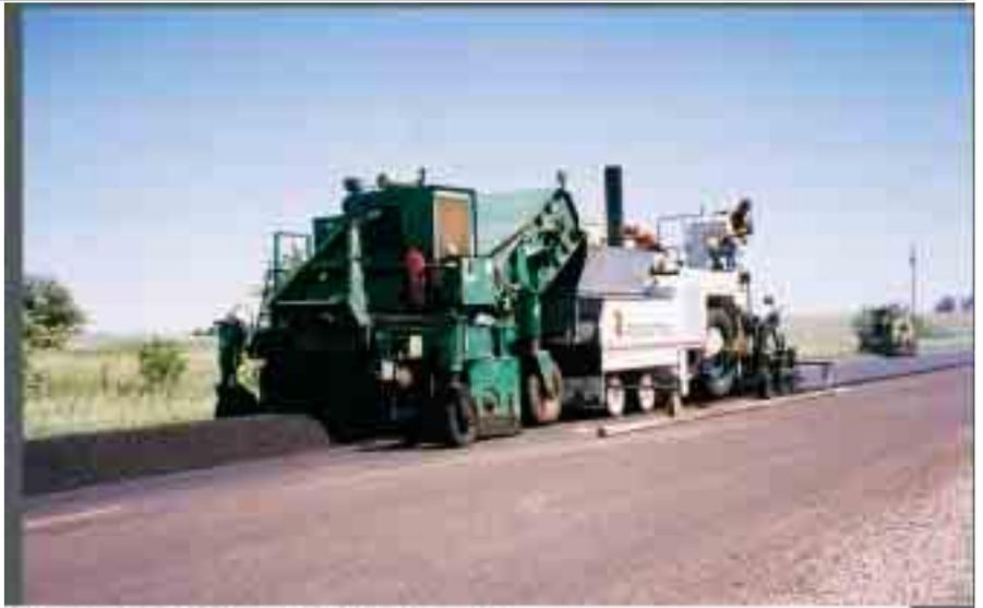
**MAQUINA RECOLECTORA DE HILERAS SOBRE PAVIMENTADORA**
