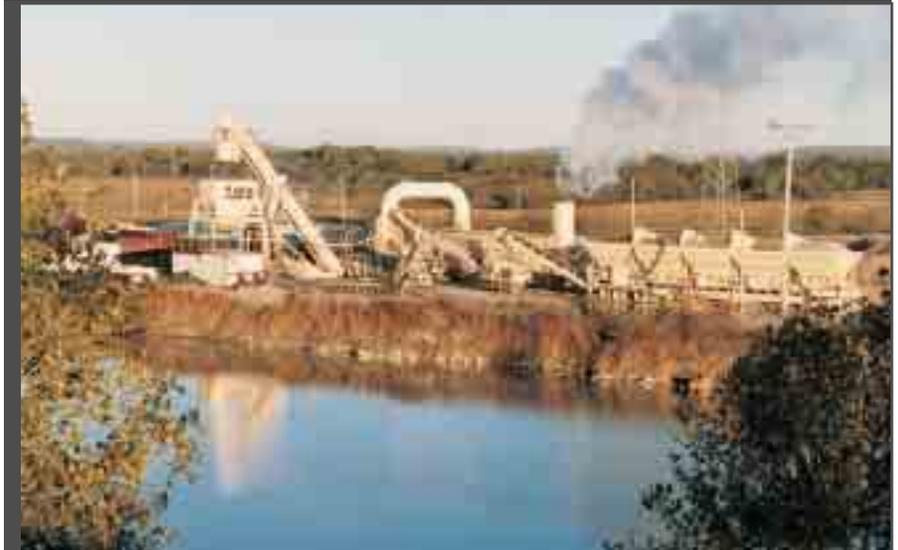
**TUBO DE DESCARGA CON PENACHO DE VAPOR (HUMEDAD)**
