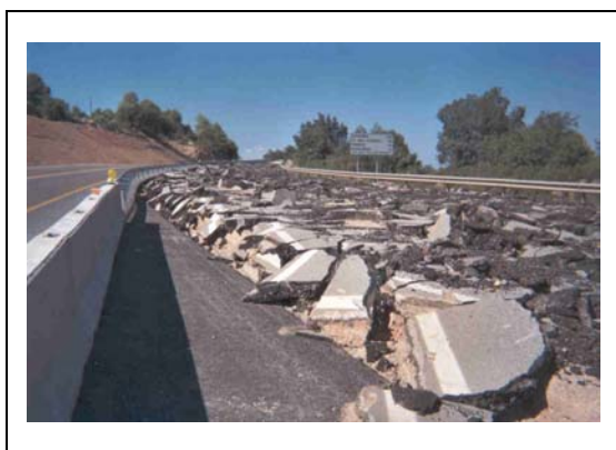
Fig. 3.4.1 Demolición mecánica de un firme
