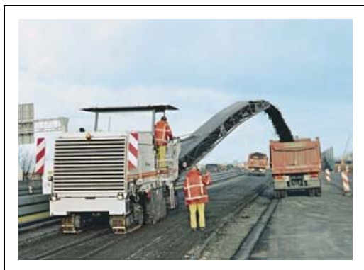
Fig. 3.3.1 Obtención de MBR mediante el fresado de pavimentos
