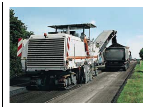
Fig. 3.4.2 Fresado de capas bituminosas envejecidas
