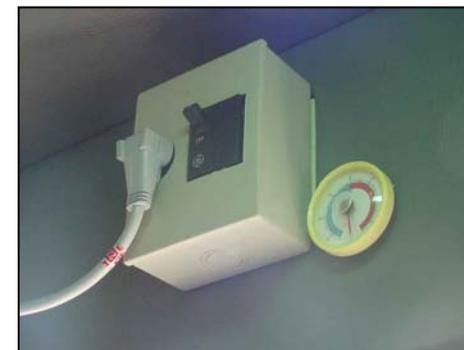
Termômetro indicador de temperatura no interior da cabine e chave p/ o ar condicionado.
