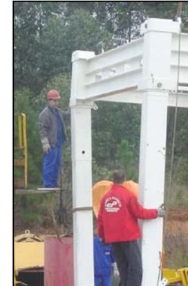
1.1. Com o quadro ainda suspenso, posicione e aparafuse os pés ao quadro base.
