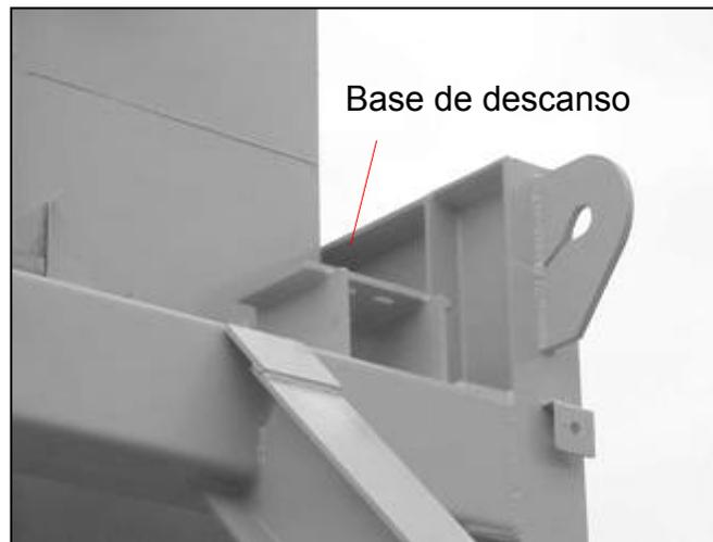
Apoio rebatível – esta peça deve ser rebatida 180° para fora, quando o silo já estiver no alto, de forma que se posicione sobre a base de descanso. Porém, entre ela e a base deverá ser montada uma coluna espaçadora. Este espaço preenchido pelo calço, permite a montagem de um sistema de pesagem do silo através de balança.
