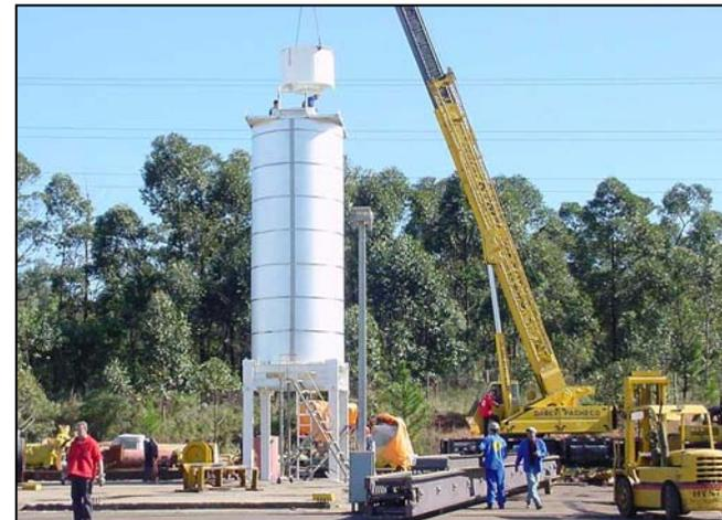
5. Utilizando dois guindastes erga o elevador e posicione-o próximo ao silo.
