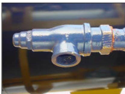
Salida inferior de la válv. de seguridad.
