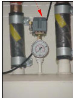
Manômetro verificador de pressão e válvula de controle.
