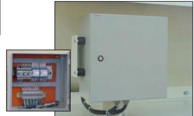
Painel dos temporizadores das válvulas de pulso e temperatura
