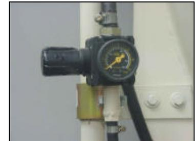
Válvula para regulagem da pressão de entrada do ar comprimido.
