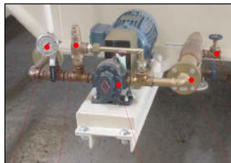
A função desta bomba (Pos.1) é de bombear o óleo combustível sob pressão ao bico atomizador do queimador. A pressão do fluido é controlada por uma válvula de alívio (Pos.2) e monitorada por um manômetro (Fig.3), colocado na linha de pressão, que já vem regulada de fábrica para permitir que a bomba forneça uma pressão de 6 kgf/ cm<sup>2</sup>.
