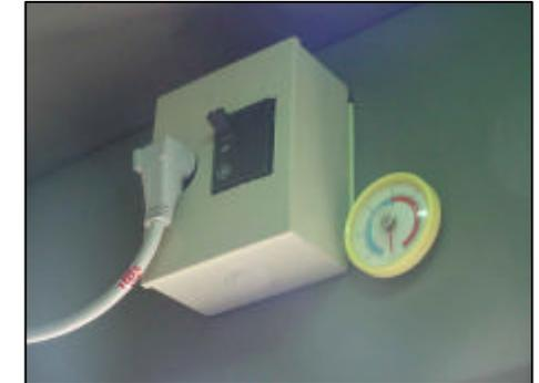
Termômetro indicador de temperatura no interior da cabine e chave p/ o ar condicionado.
