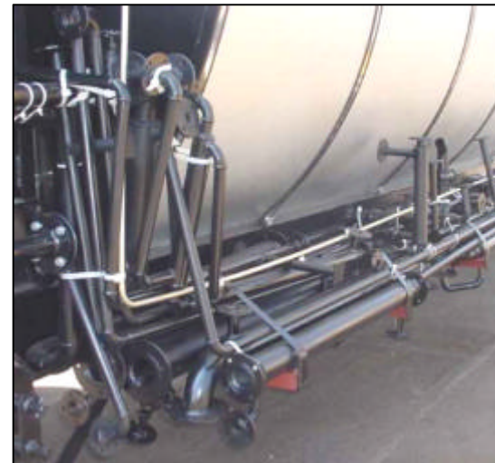
Tubulações de interligação da tancagem.
