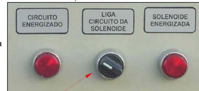
Chave lig/desl. válvula solenóide.
