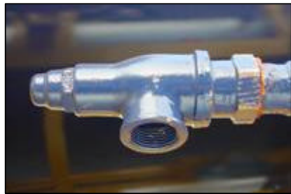
Saída inferior da válv. de segurança.
