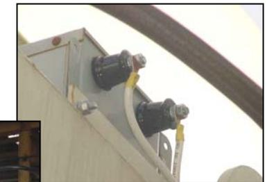
Conexión de cables de los electrodos en el transformador.
