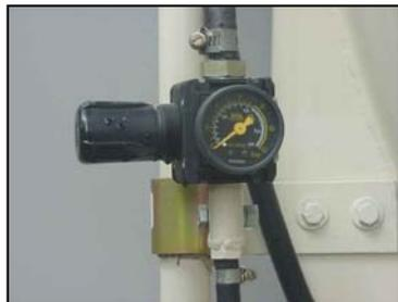
Válvula para regulado de la presión de entrada del aire comprimido.
