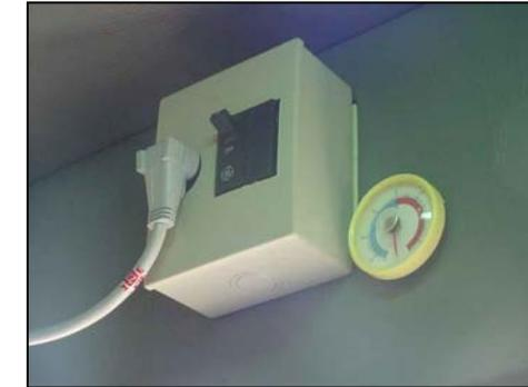
Termómetro indicador de temperatura en el interior de la cabina y llave p/ el aire acondicionado.
