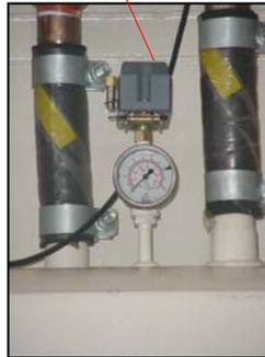
Manómetro verificador de presión y válvula de control.
