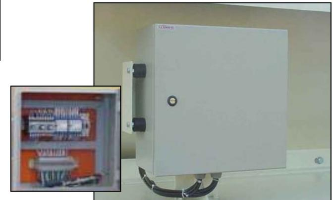
Panel de los temporizadores de las válvulas de pulso y temperatura
