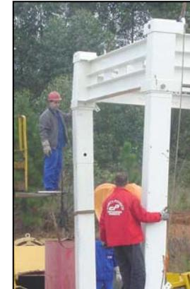
1.2. Os pés do equipamento devem ser apoiados sobre bases de concreto e sapatas\* adequadas para a distribuição de carga no solo, e compatível com a capacidade de suporte deste.
