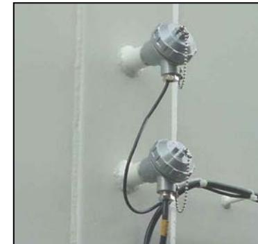
Sensor PT-100, localizado na parede lateral do filtro
