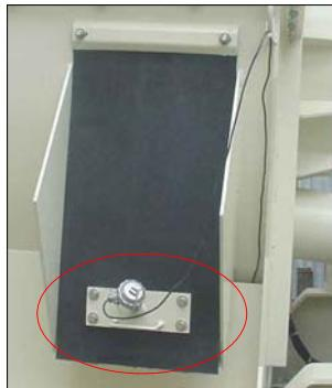
Sensor PT-100, localizado na calha de descarga de material do secador
