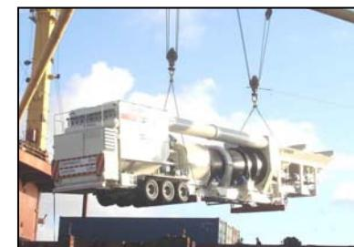
Atenção para os pontos de posicionamento dos spreaders.
