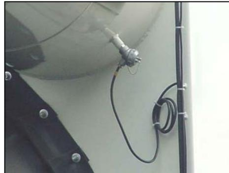
Sensor PT-100, localizado na tubulação de exaustão dos gases
