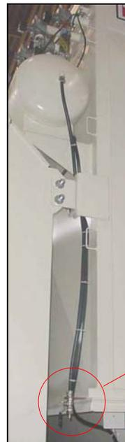
Dreno de água do depósito de ar: drenar 3 vezes ao dia.
