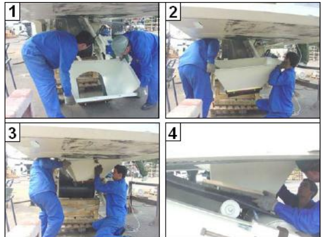
Figura 1 – Montaje de la Criba
