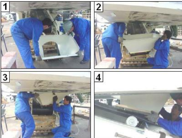
Figura 1 – Montaje de la Criba
