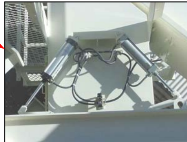
Silo 25 m3 Comporta de descarga do pré-silo para o silo principal.
