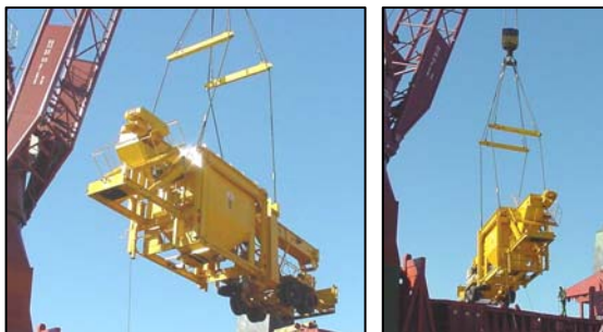
Com a utilização de spreader (E) With the spreader system
