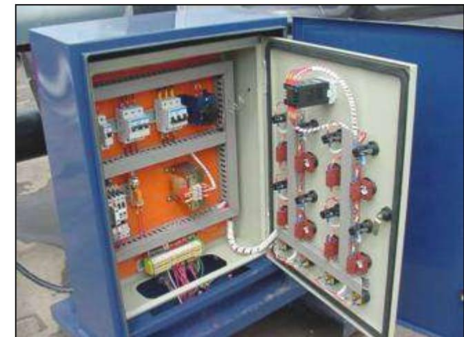
**AQUECEDORES MOVEIS:** Nestes modelos o painel de comando está fixado sobre a mesma base da bomba de circulação do fluido, localizada no lado direito do conjunto, de forma afastada do corpo para reduzir a influência do calor desta para o quadro, eliminando os riscos de superaquecimento.
