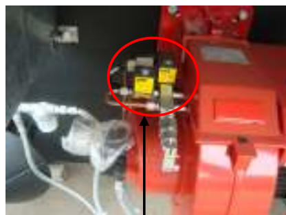
22049186 – Bobina válvula solenóide
