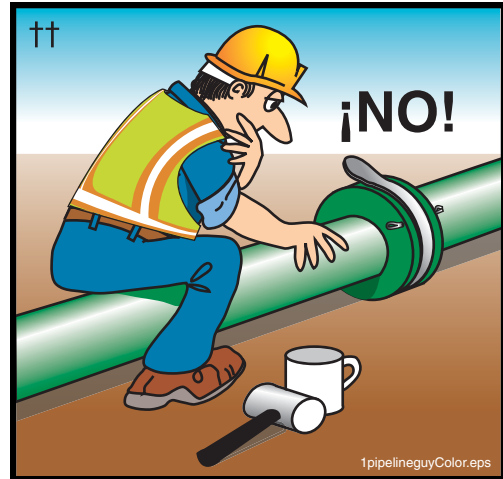
Figura 51 Nunca se ponga a horcajadas o se siente sobre una tubería presurizada
