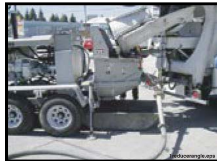
Figura 22 Siempre apunte los reductores alejándolos del operario y del conductor
