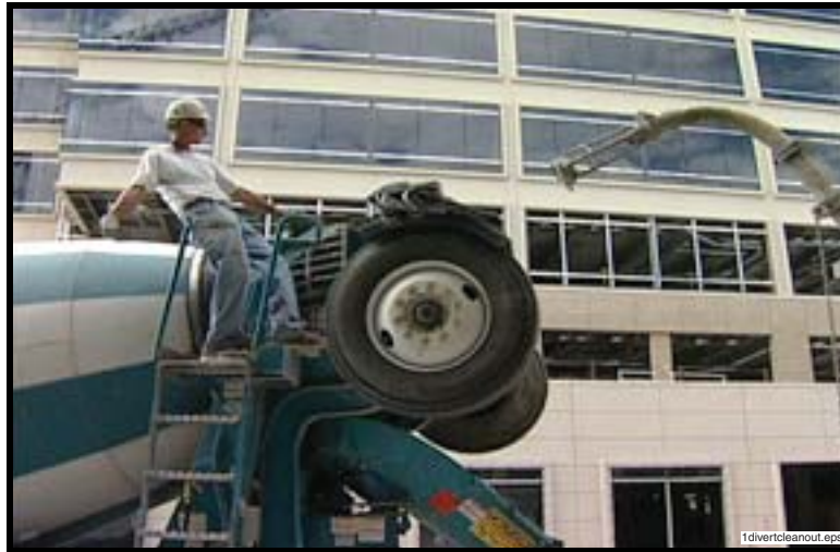
Figura 32 Desvíe la tubería vertical al área de limpieza y asegúrese de fijar la descarga antes de continuar
