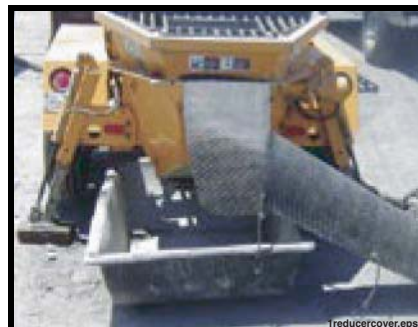
Figura 23 Cubra los reductores y use cajas de contención para la limpieza
