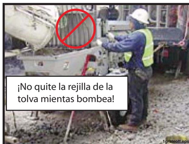
Figura 24 Nunca quite la rejilla de la tolva mientras la bomba está funcionando
