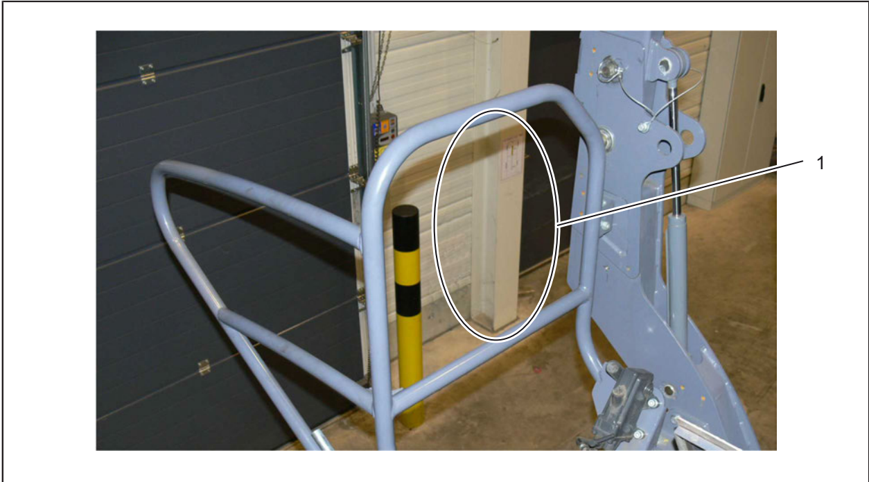
Att. 2-11: Ugunsdzēsamā aparāta vieta
