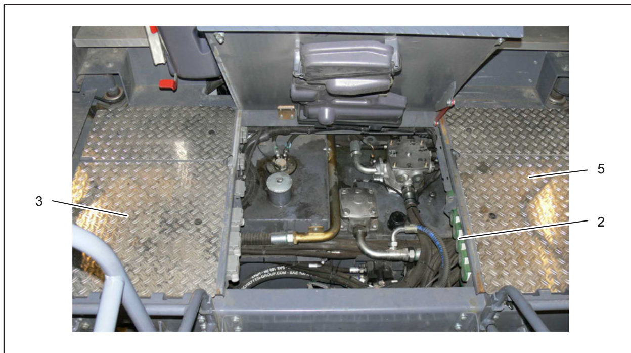
Fig. 2-89: Instalația electrică (II)
